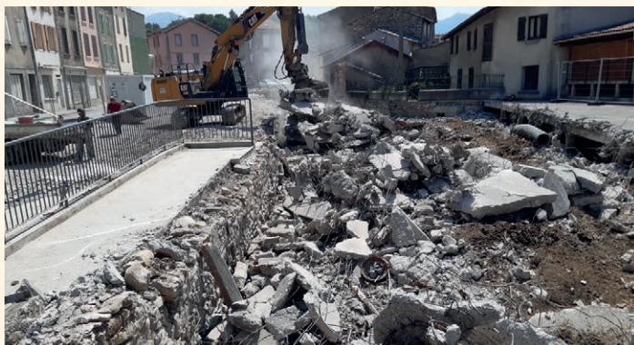
Pendant les travaux
