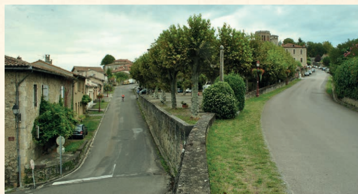
Les bas-côtés enherbés à Saint-Lizier délimitent clairement la chaussée tout en favorisant l'infiltration.
