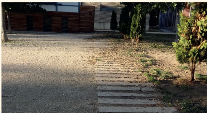
Matérialisation d'un cheminement par des dalles en pierre naturelle pour laisser la majorité de l'espace en grave concassée, revêtement de sol perméable.
