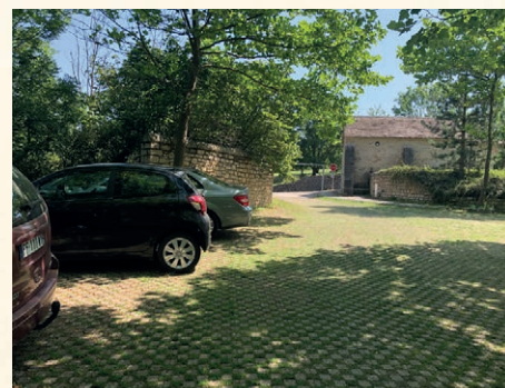
Parking sur dalles alvéolées enherbées à Quézac.
