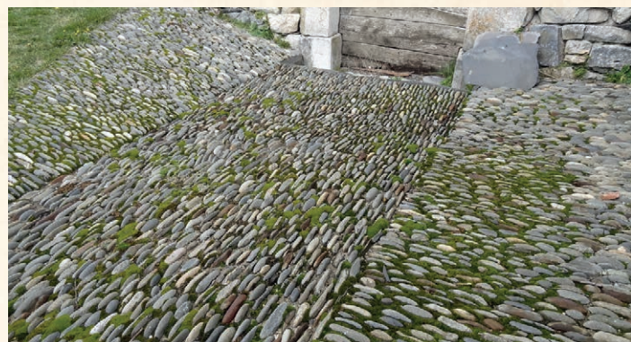
Cette calade au seuil d'une église à Galey constitue un revêtement à la fois patrimonial et perméable.
