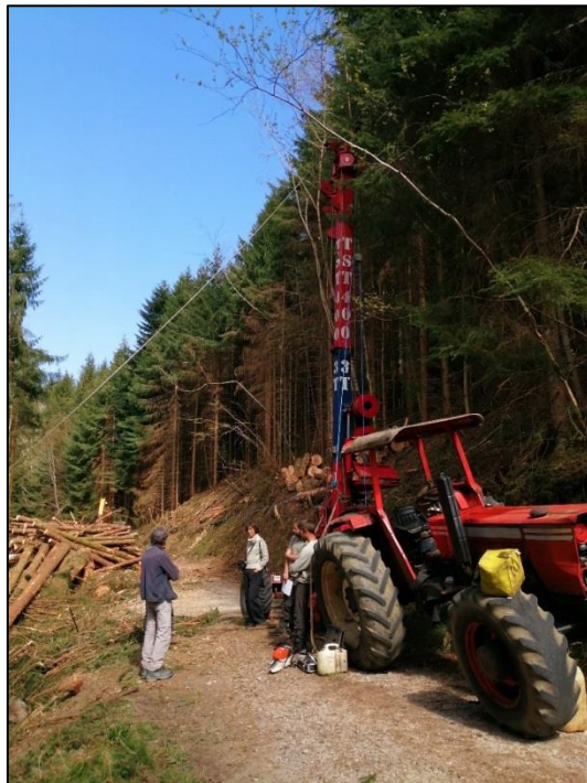
Chantier câble réalisé par Aéro Bois dans le Comminges, à Arbas (31).
