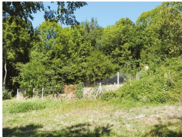
25. Cazenave-Allens / station d'épuration
