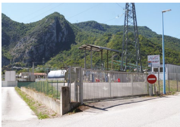
410. Tarascon-sur-Ariège / centrale électrique
