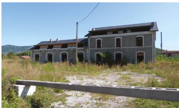
31. Saint-Paul-de-Jarrat / bâtiment désaffecté
