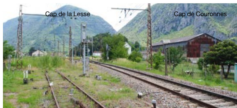
Vue de la gare de Tarascon ©PnrPA
